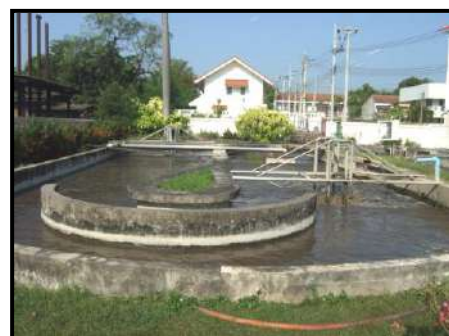
คลวงวนเวียน เป็นการเติมออกซิเจนในน้ำโดยใช้เครื่องตีน้ำ
