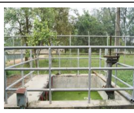
สถานีสูบน้ำเสียต้นทาง บ่อสูบน้ำปลายทาง ระบบบำบัดน้ำเสียแบบบ่อผึ่ง
